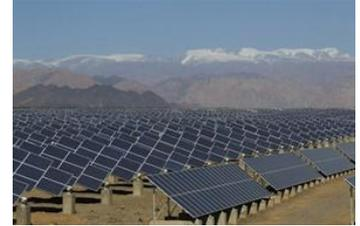
Les installations qui peuvent être raccordées au réseau sont composées de modules solaires, constitués eux-mêmes de cellules photovoltaïques. Ces générateurs transforment directement l'énergie solaire en énergie électrique (courant continu).
